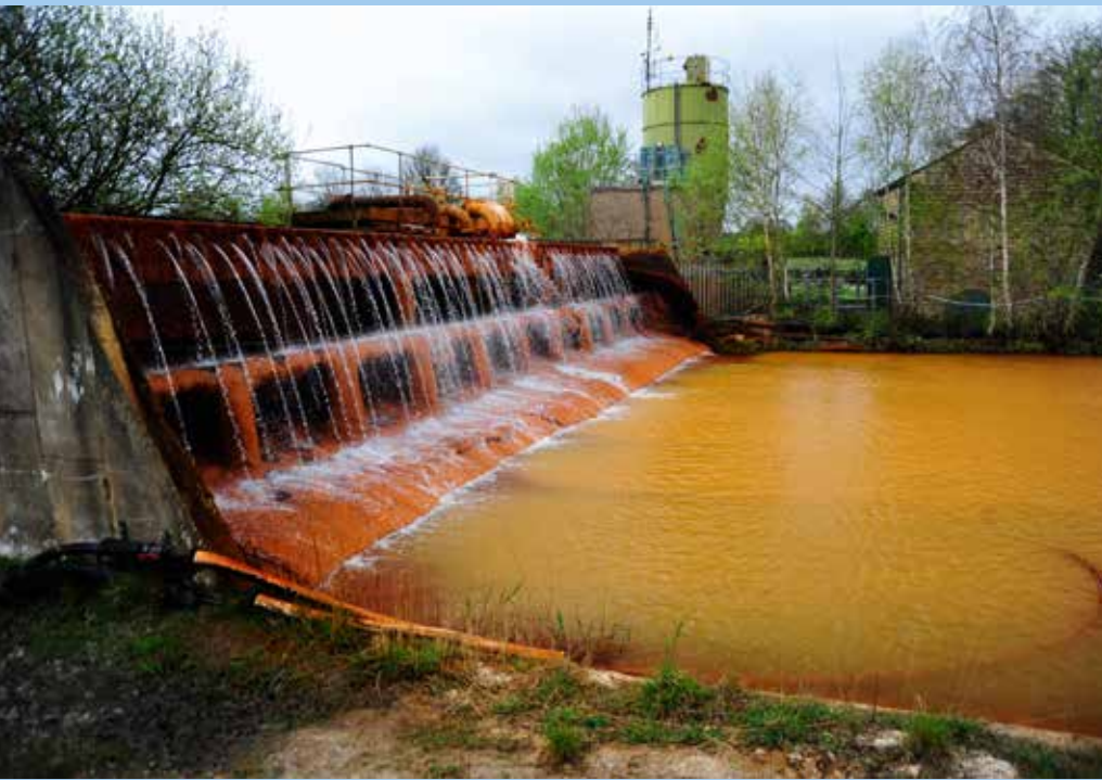
Abb. 48: Belüftungssystem der Grubenwasseraufbereitungsanlage am Bergwerk Caphouse in Yorkshire (Großbritannien; Foto: Bastian Reker).
