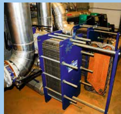
Abb. 56: Nachteil des Systems mit offenem Kreislauf: Verockerungen an den Wärmetauschern (ockerfarbene Bereiche auf der Metallplatte; Foto: Bastian Reker).
